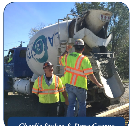
Charlie Stokes & Dave George Mock Concrete Closure Pour
